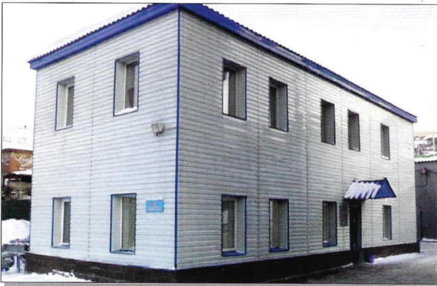
Пункт технического обслуживания пассажирских вагонов ст. Уфа
